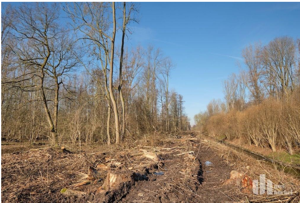
Beginn der Arbeiten im Februar 2021
