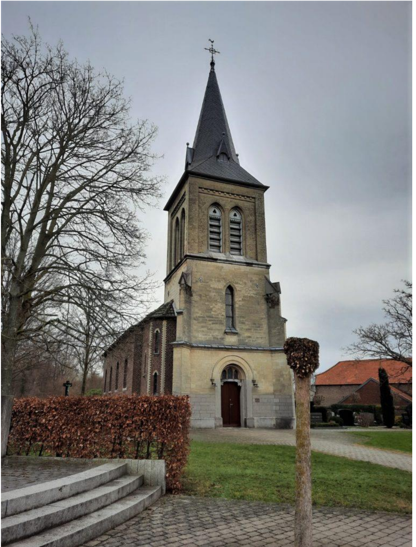
Pfarrkirche St. Severinus in Selfkant – Wehr
